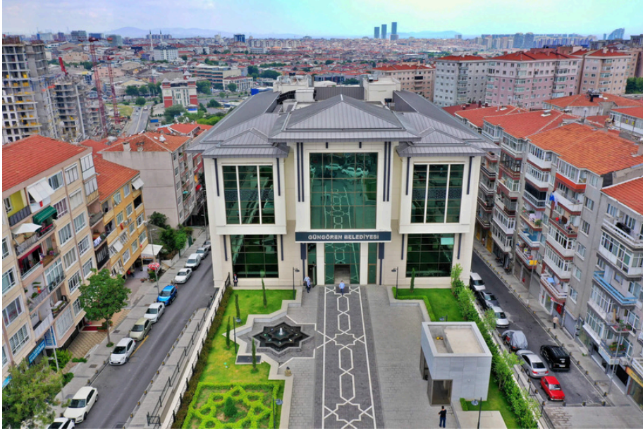
Güngören Belediye Binası Ses -Işık Sistemi
